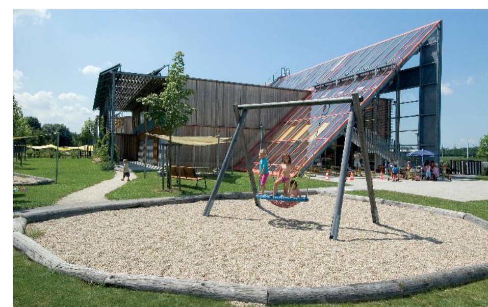
Kindergarten [Source: Mag. Stadt Linz, Archiv]
