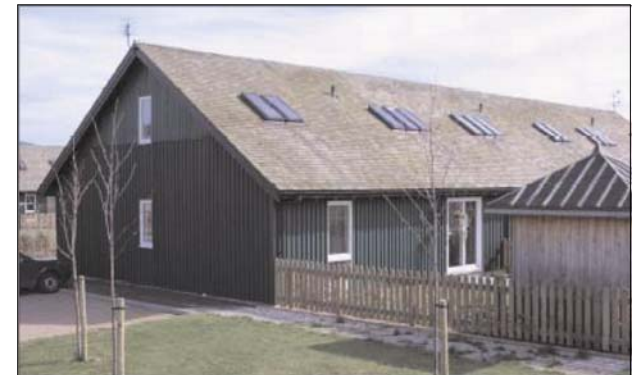
Viviendas sociales descritas por Fionn Stevenson
